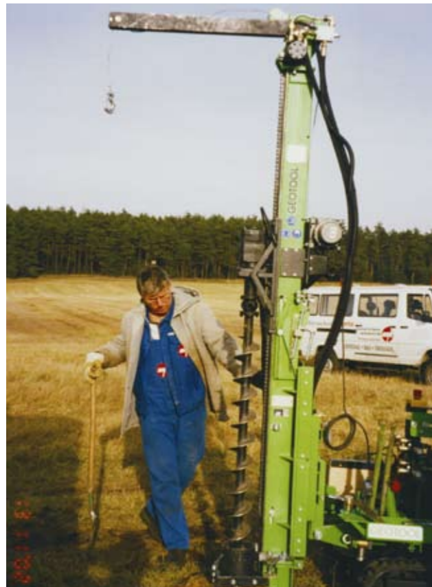
Abteufen einer Bohrung mit Kleinbohrgerät (Foto: GMB)
