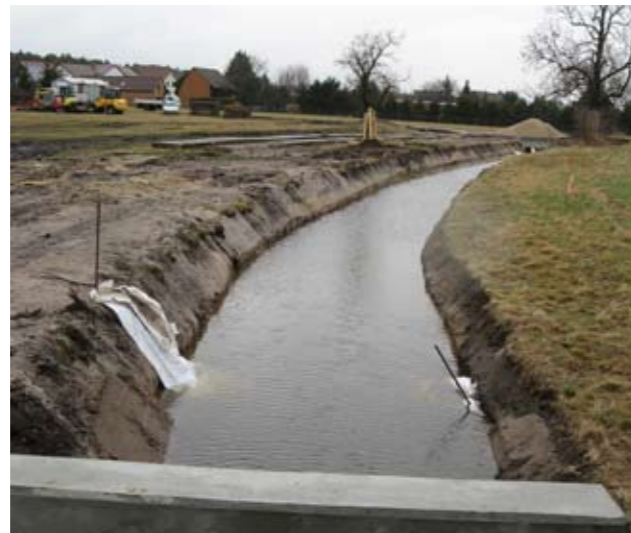
Schleifer Dorfgraben zwischen Mittelweg und Struga nach erfolgter Gewässerunterhaltung (Foto: ITL)
